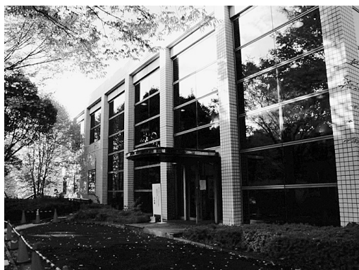
A 会場となった基礎融合材料実験棟
